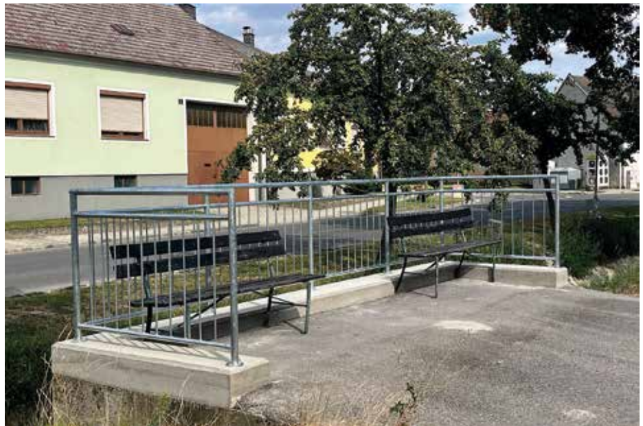
Neues Sicherheitsgeländer in Bogenneusiedl
