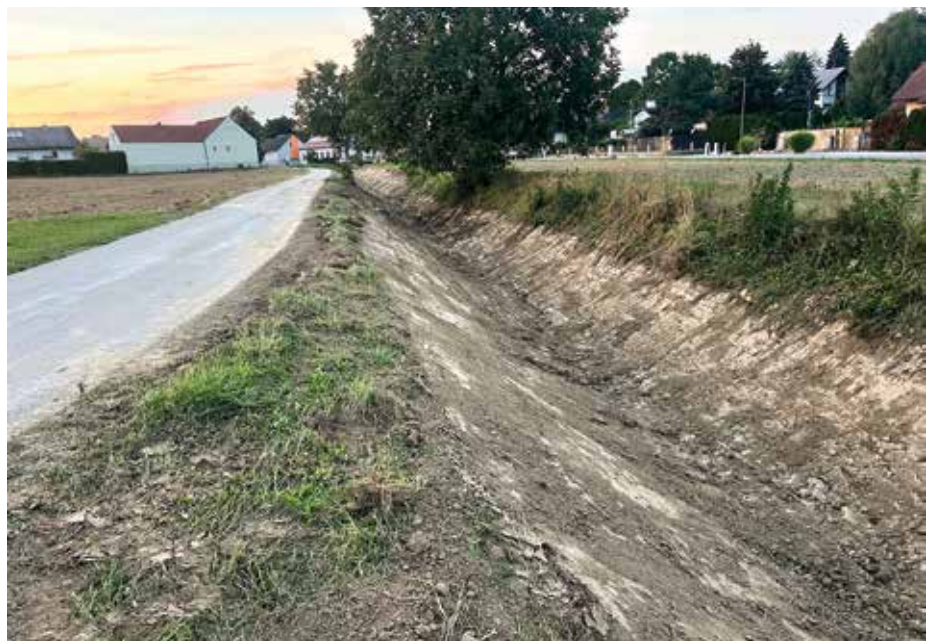
Beräumung des Baches
