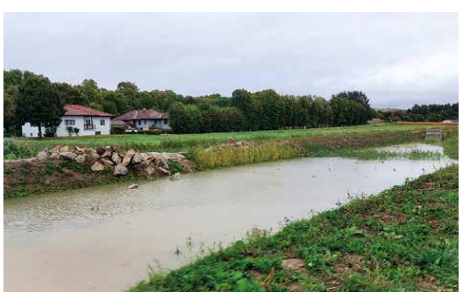
Hochwasserschutz: Becken Wiesthal
